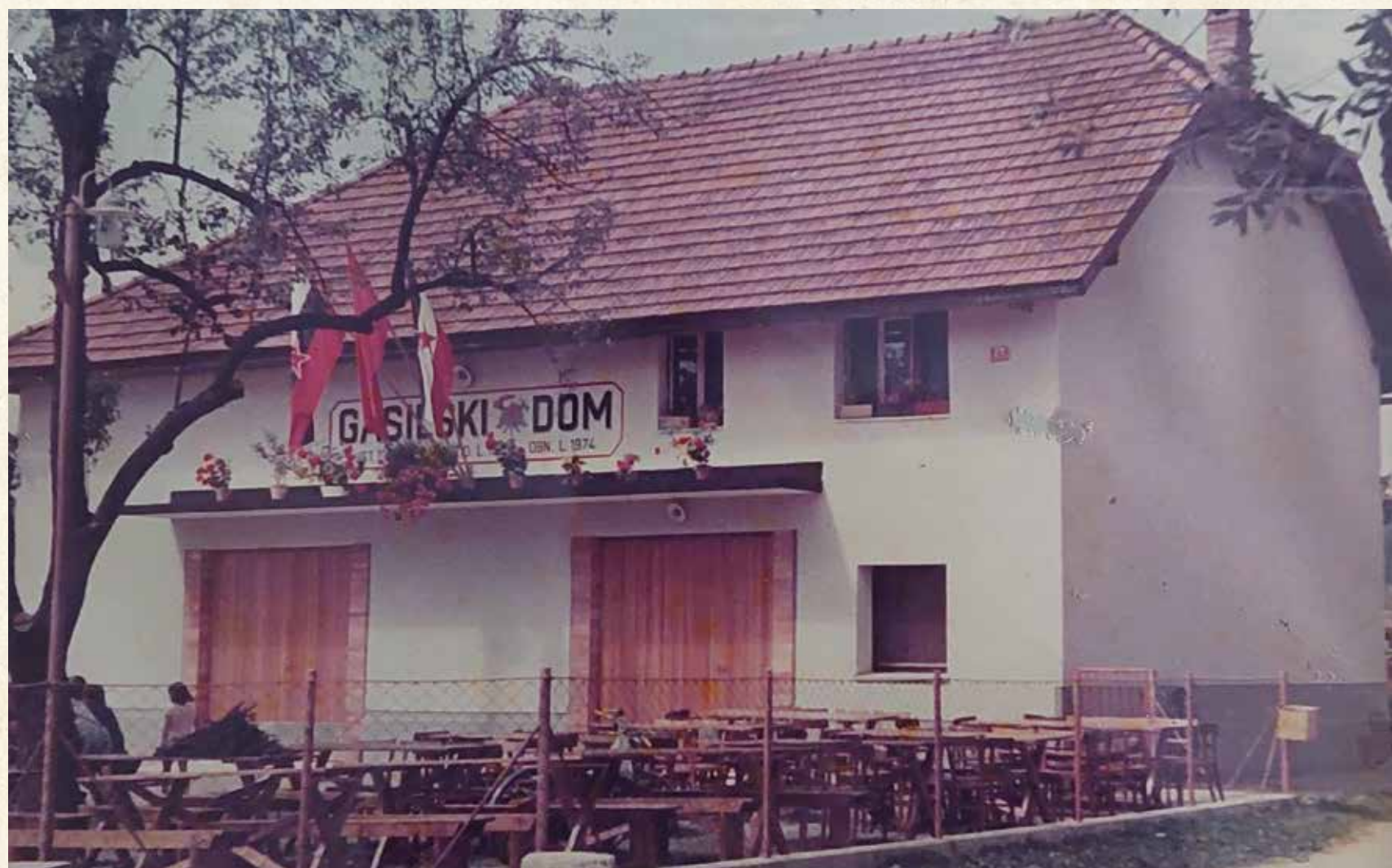
Prenovljen gasilski dom.
